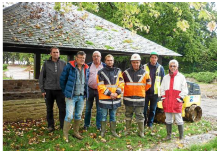
À côté des élus et techniciens, André Jézéquel (à droite) est venu constater l'avancement des travaux à Kéréllon.
